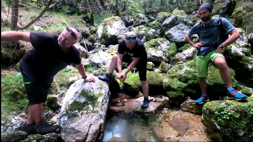
Preparazioni basi e supporti per stazioni di controllo
