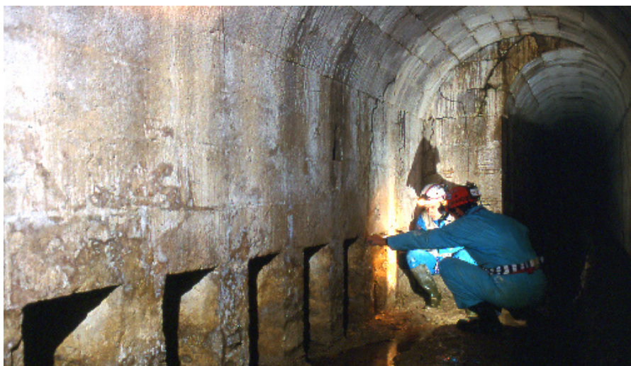
Figura 6 - Bocche di captazione nella struttura semi-sotterranea della Presa (Foto: M. Traverso).
