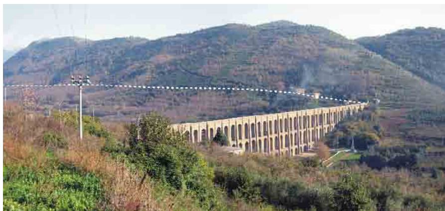
Figura 6 - Panoramica della struttura ad archi dei Ponti della Valle e del colle di Longano lungo i cui fianchi si sviluppa il tracciato ipogeo (evidenziato dal tratteggio) dell'acquedotto Carolino (foto S. Del Prete).
