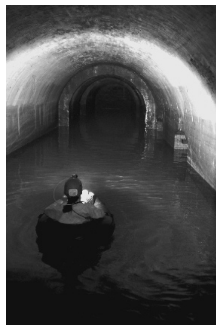
Ancona, Cisterna settecentesca di Piazza Cavour.
