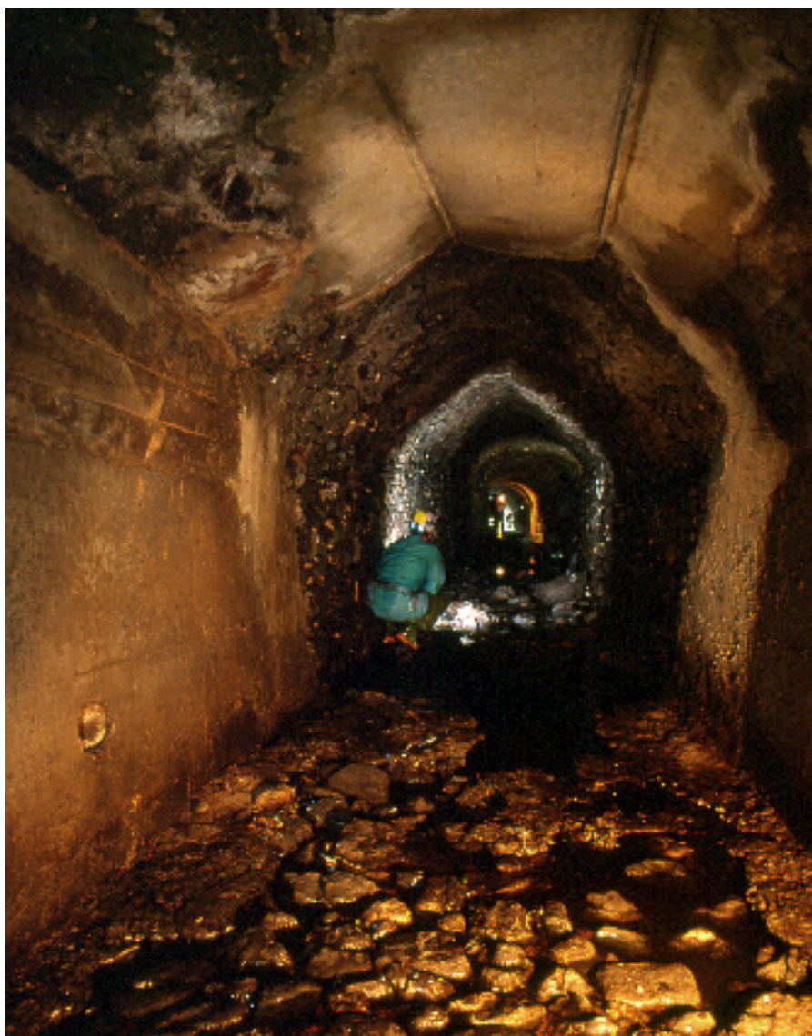
Figura 14 - Roggia dei Mulini, Genova. Tratto della galleria nella quale si notano le differenti tessiture murarie. In particolare si riscontra un profilo della copertura curiosamente poligonale (Foto: M. Traverso).
