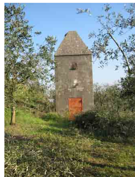
Figura 7 - Torrino di ventilazione dell'acquedotto Carolino (Foto S. Del Prete).
