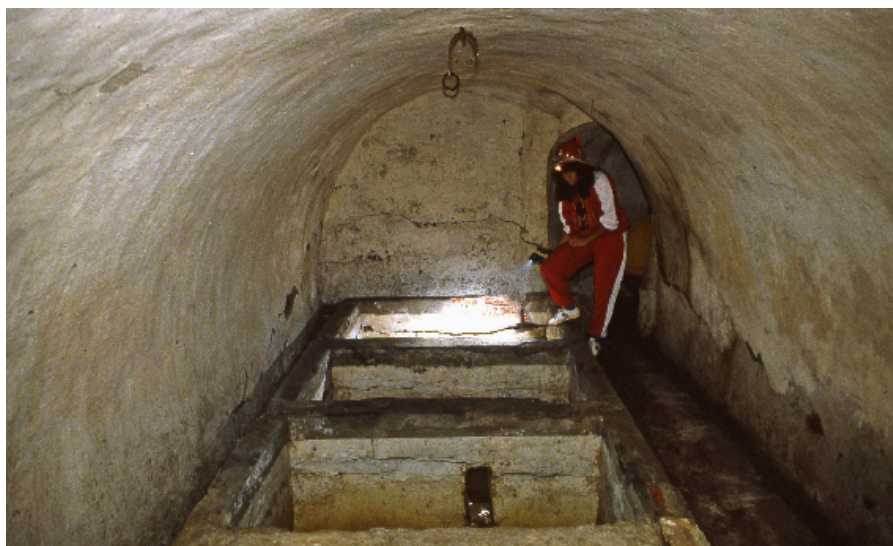
Figura 7 - Interno del vano iniziale del Capofonte Teresiano (n. CA 1 FVG-TS), con i tre bacini di filtraggio dell'acqua. (Foto: P. Guglia)
