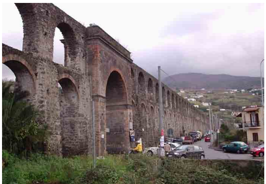
Figura 12 - Tratto su archi dell'acquedotto di Buceto in loc. Pilastrì al confine tra i comuni di Ischia e Barano (Foto L. Di Iorio).
