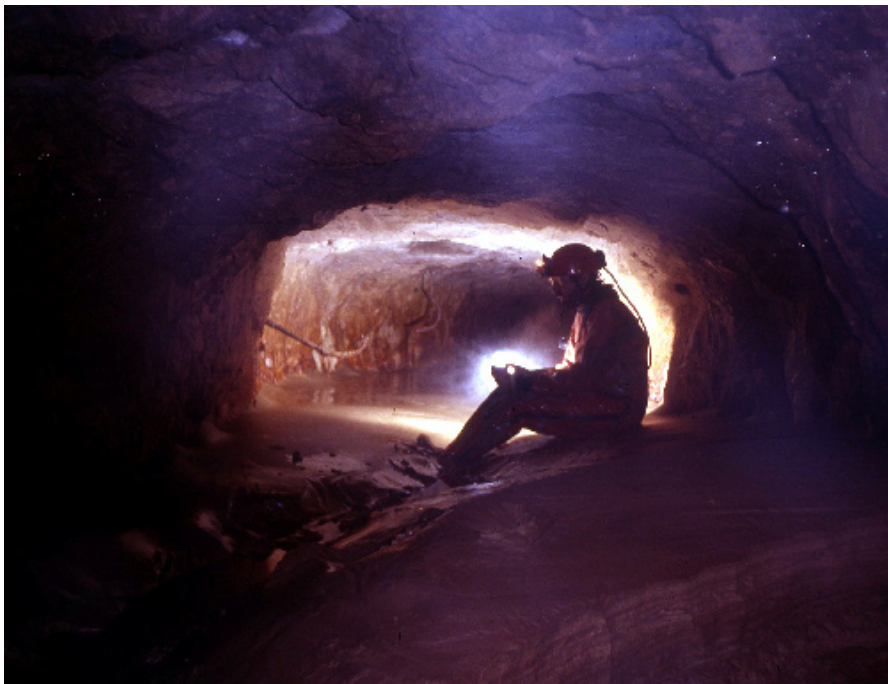
Galleria delle sorgenti di Aurisina, CA 97 FVG-TS. Cunicolo di captazione, interessato da un ricco deposito di argilla, che si inoltra per 300 metri nella massa calcarea (Foto: Paolo Guglia).
