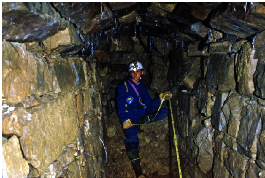
Galleria Kaluza, CA 8 FVG-TS. Cunicolo di captazione risalente al XIX secolo, posto sotto la chiesa di San Ulderico nel paese di San Dorligo della Valle (Foto Paolo Guglia).
