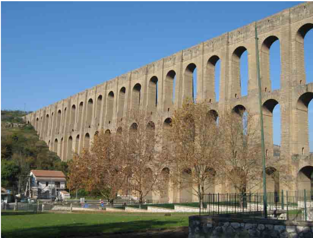
Figura 8 - La struttura dei Ponti della Valle si sovrappone al tracciato interrato dell'acquedotto del Carmignano nella stretta gola di Valle di Maddaloni (foto S. Del Prete).
