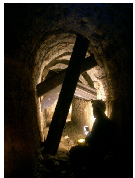
Figura 1 - Acquedotto Storico, Genova. Tratto della galleria di una presunta diramazione. La volta è stata puntellata in epoca sconosciuta con antichi stipiti di ardesia lavorata (Foto: G. Barranco).
