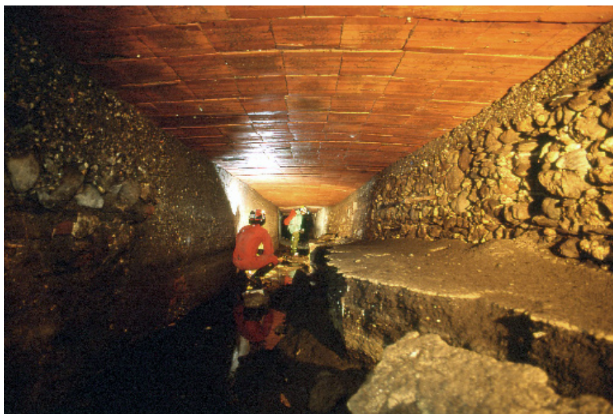
Figura 13 - Roggia dei Mulini, Genova. Tratto della galleria in cui la copertura è stata rimaneggiata in tempi recenti. Si noti il notevole spessore del sedime (Foto: M. Traverso).
