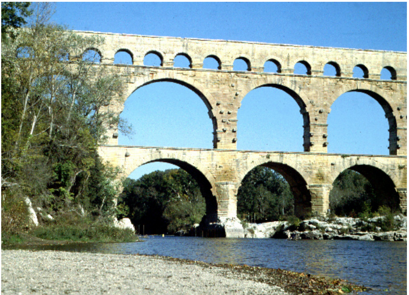
Figura 2: le arcate del Pont du Gard, in Francia, famoso non solo per la sua bellezza, ma anche per le sue dimensioni (275 m di lunghezza per 49 di altezza). Il ponte scavalca la valle del fiume Gard ed era parte integrante dell'acquedotto di Nimes (Foto Carlo Germani).
