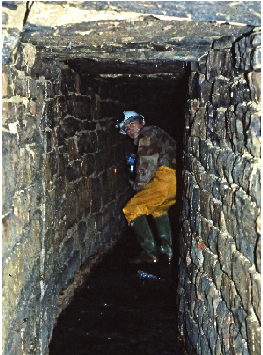
Acquedotto Romano, CA 9 FVG-TS. Tratto della galleria ancora percorribile, posta sotto la via Madonna del Mare, che rappresenta la parte terminale dell'acquedotto romano di Bagnoli (Foto Paolo Guglia).
