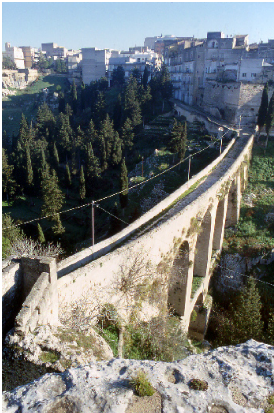
Figura 3 - Il Ponte-Canale, che portava l'acqua dal Partitore dell'acquedotto sotterraneo alla Fontana della Stella, ai margini della città, sul lato opposto del torrente Gravina (Foto: M. Traverso).
