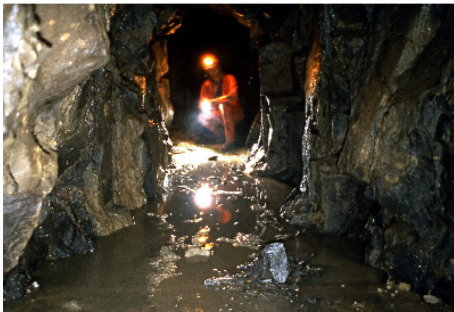
Figura 8 - Le cosiddette gallerie superiori (n. CA 2 FVG-TS) rappresentano il livello più alto dell'acquedotto Teresiano, scavato direttamente nella roccia marnoso/arenacea senza alcun rivestimento. (Foto: P. Guglia)
