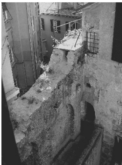
Figura 2 - Resti di uno dei ponti-canale con i quali l'Acquedotto Storico di Genova si manteneva in quota (Foto: A. Bixio).
