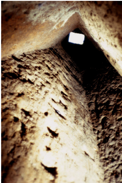
Figura 9 - Veduta dal basso di pozzo etrusco a sezione rettangolare, con ingresso ruotato. (Foto Gruppo Grotte Recanati).
