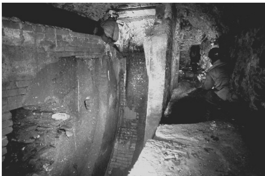
Figura 10 - Roggia dei Mulini, Genova. Il salto d'acqua era sufficiente a movimentare la ruota che, in origine, era collocata su questo scivolo (Foto: Mauro Traverso).
