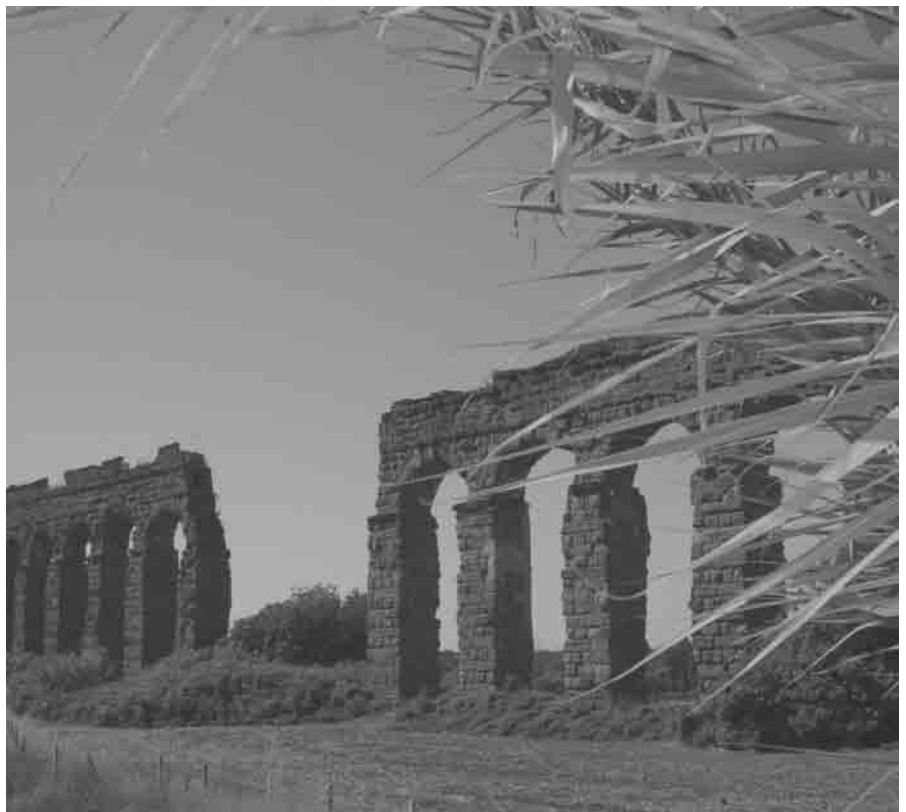
Figura 5: le arcate di un acquedotto nei dintorni di Roma. (Foto: Carla Galeazzi)
