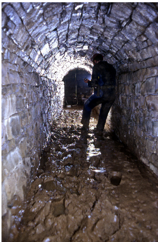
Figura 10 - Nonostante i depositi di fango e la mancanza di manutenzione, la galleria principale del Complesso Store (n. CA 158 FVG-TS) presenta ancora oggi lo scorrimento di una discreta quantità d'acqua, usata per l'irrigazione dei campi soprastanti.
