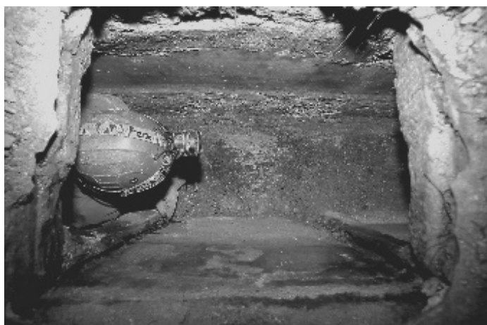
Figura 6 - Acquedotto Storico, Genova. Botola di accesso ad uno dei tratti più antichi, scavato in trincea. Ritenuto scomparso, è stato individuato sotto il piano asfaltato di una piazza (foto: M. Traverso).
