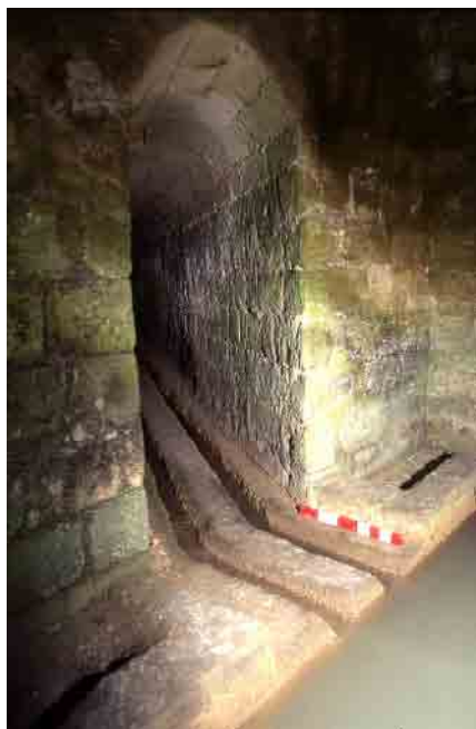
Figura 7 -Vasca del Partitore, all'estremità a valle dell'acquedotto: qui confluiscono le canalette per il deflusso dell'acqua (Foto: G. Bologna).
