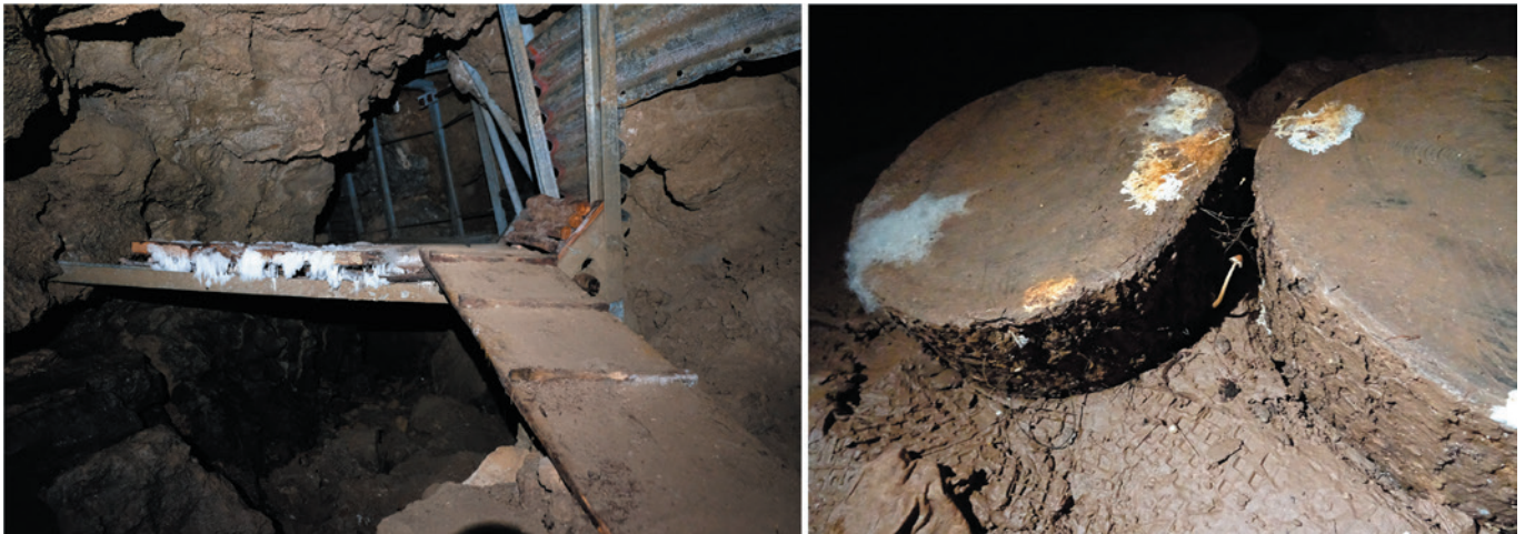
Figura 2 - Esempio di passerelle in legno visibilmente degradate in una grotta in Emilia-Romagna (sinistra) e in Bosnia (destra). Il legno è un materiale da evitare in grotta perché degrada facilmente e introduce potenziali fonti di contaminazione organica (es. funghi, muffe e batteri).
